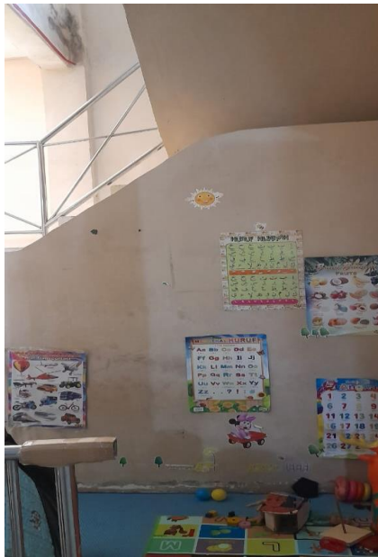
Gambar 11. Ruang Ramah/Tunggu/Bermain Anak Sebelum Upgrading Desain
