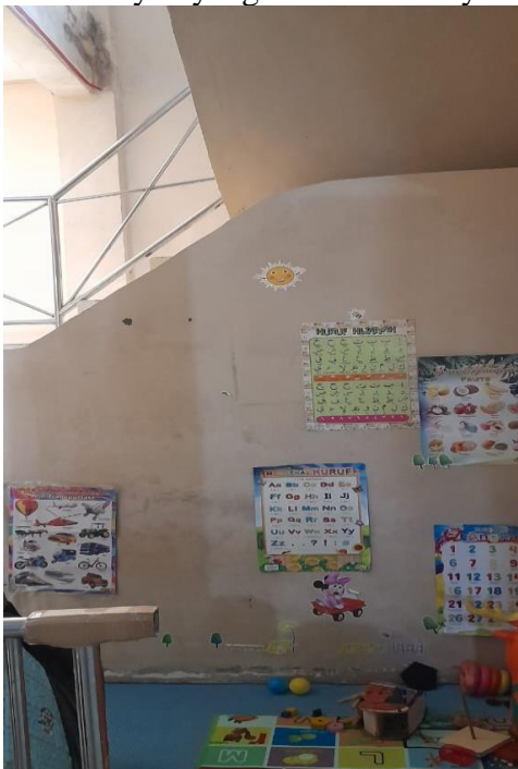
Gambar 19. Ruang Ramah/Tunggu/Bermain Anak Sebelum Upgrading Desain
