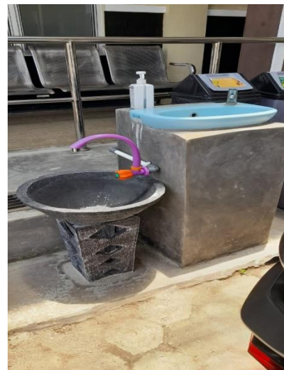
Gambar 10. Wastafel Sesudah Upgrading Desain (Sudah memiliki wastafel anak)
