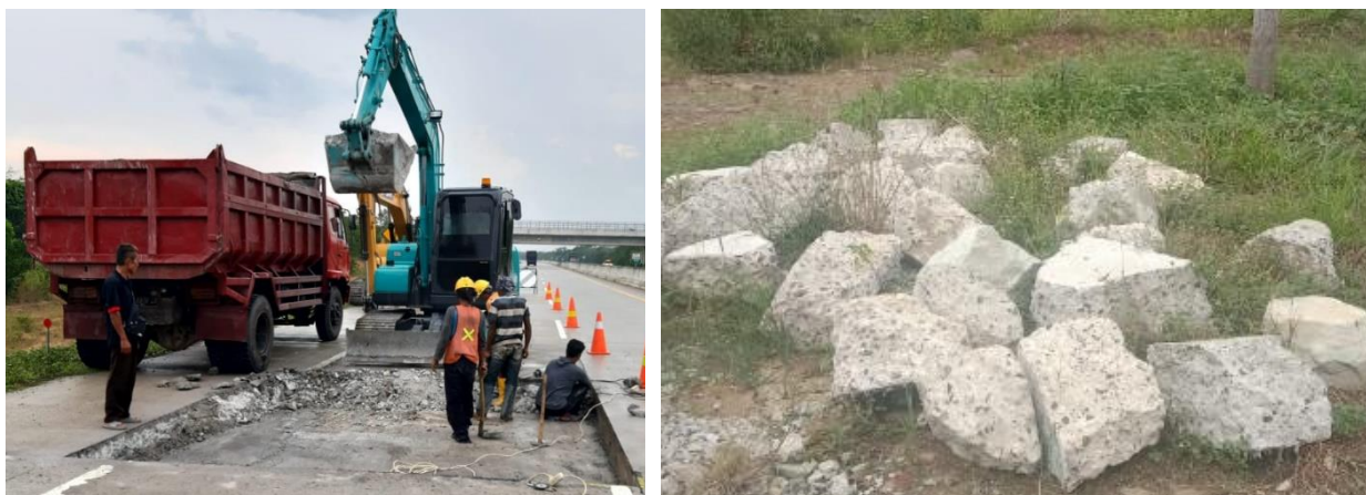
Gambar 1. Pembongkaran rigid pavement pada jalan tol trans sumatera (JTTS)-Lampung
